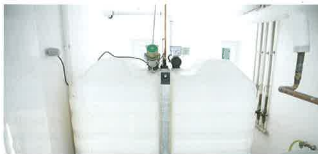
Moderne, doppelwandige Kunststofftanks sind platzsparend, geruchssicher und für alternative flüssige Brennstoffe geeignet.
